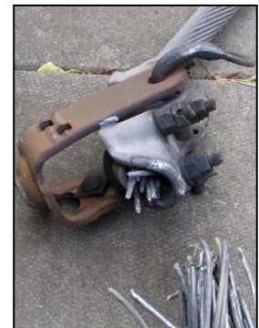
Ruptura de conductor debido a una fatiga por vibración eólica
